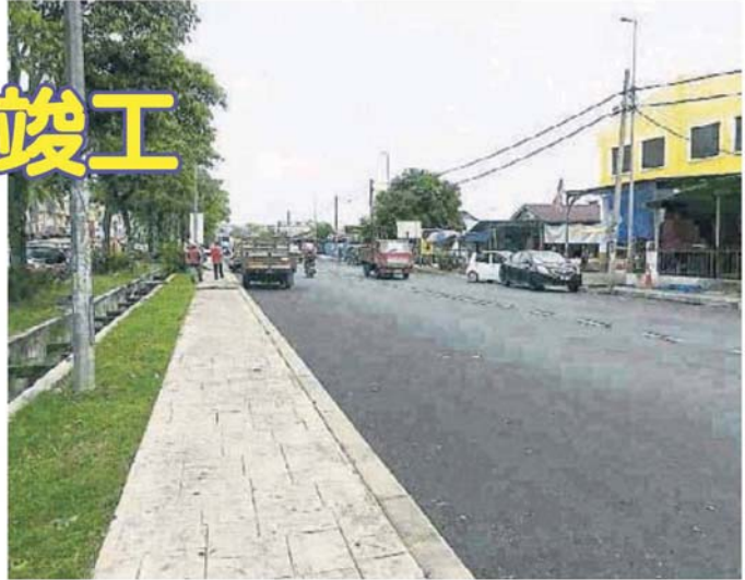
■屬繁忙路段的SK6/1路重鋪工作已完成。
